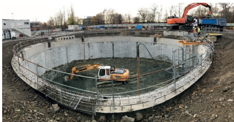
Bassin de stockage-restitution ZAC des Sauzes (Fin 2020 : phase de terrassement).
